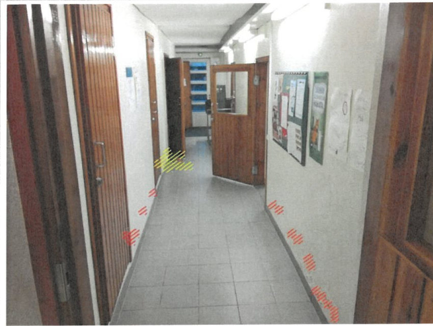
Käytävä. Lattian lukemat 69-81= normaalia
