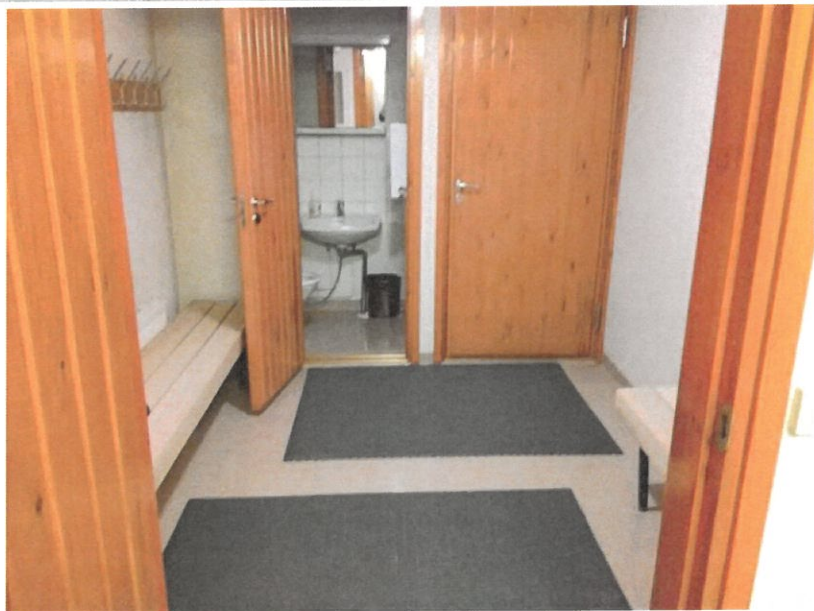
Poikien pukuhuone ja wc. Lattiat Gann 78-95=kosteita
