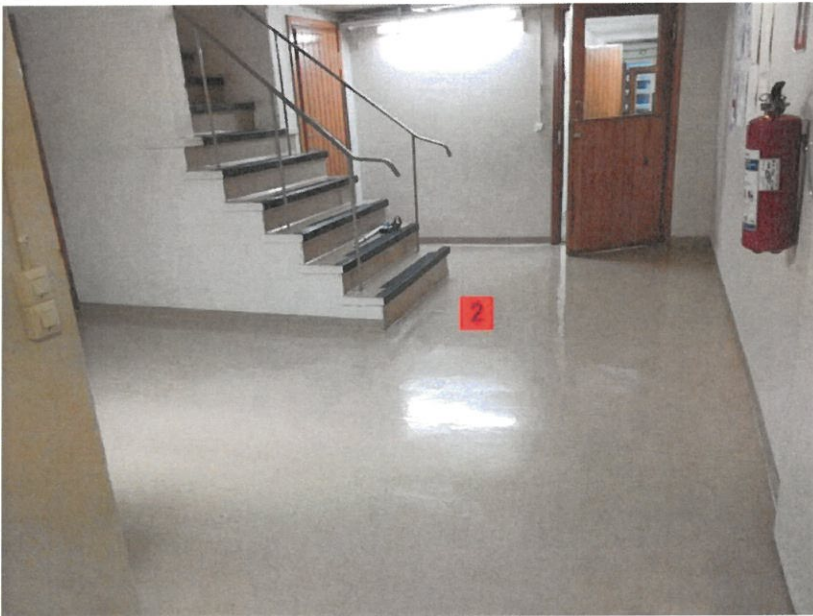
Muovimaton alusta mitattiin myös Vaisalan mittarilla ja suhteellinen kosteus oli 95%-20°C= kostea
